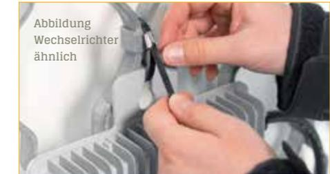
**5** Legen Sie den Platz für den Wechselrichter fest. Befestigen Sie diesen mit einem der beigelegten Montagebänder. Sobald das/die PV-Module sicher angebracht sind, können Sie mit dem Anschluss des Wechselrichters fortfahren (ab S. 24).
