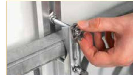
**4** Befestigen Sie die Gewindebolzen durch festziehen der Sperrzahnmuttern. Danach können Sie das PV-Modul mit den Klemmkralen und den Flügelmuttern stabil am Gelände befestigen.
