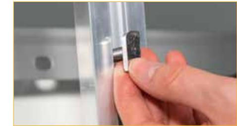
**2** Befestigen Sie die Alu-Profile mit jeweils zwei M8x20 Hammerkopfschrauben und Sperrzahnmuttern durch die vorgesehenen Bohrungen am PV-Modul.
