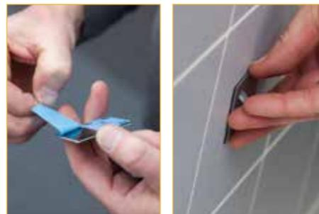
**3** Platzieren Sie 1-2 Montagehilfen möglichst mittig auf der Rückseite des/der Moduls(e) und befestigen sie diese mit Montagebändern am Geländer. Die Verwendung der Montagehilfen reduziert außerdem die mechanische Belastung des Photovoltaik-Moduls und sorgt für die Minimierung von eventuell auftretenden Windgeräuschen. Zudem bieten sie Befestigungsmöglichkeiten, falls eine Öse nicht genutzt werden kann.
