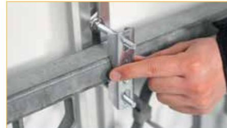
**3** Justieren Sie die Gewindebolzen durch leichtes Eindrehen etwa auf der zur Montage an Ihrem Gelände benötigten Höhe. Heben Sie das PV-Modul an die gewünschte Position. Korrigieren Sie ggf. die Position der Gewindebolzen.
