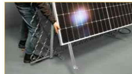
**4** Anschließend wird das Solarmodul auf der vormontierten Modulhalterung vorsichtig abgelegt. Berücksichtigen Sie dabei, dass sich die vorinstallierten Kabel des Moduls auf der Seite des Wechselrichters befinden.
