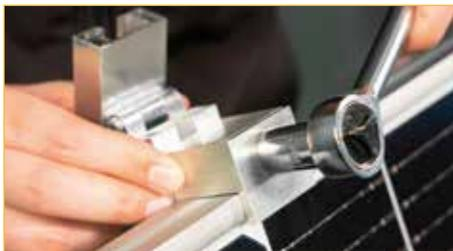
**6** ... und Sperrzahnmuttern. Ziehen Sie diese mit einem geeigneten Werkzeug fest.
