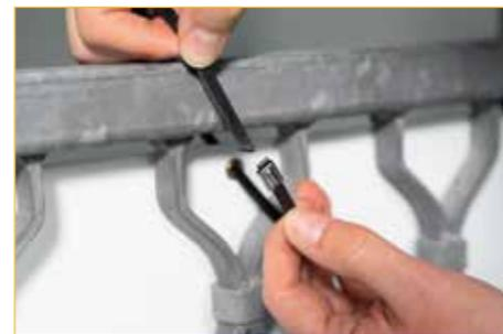
**2** Befestigen Sie die/das SunMan Flexmodul(e) mittels der Edelstahl-Montagebänder durch die Messingösen an Ihrem Balkongeländer oder anderen geeigneten Halterungen.
